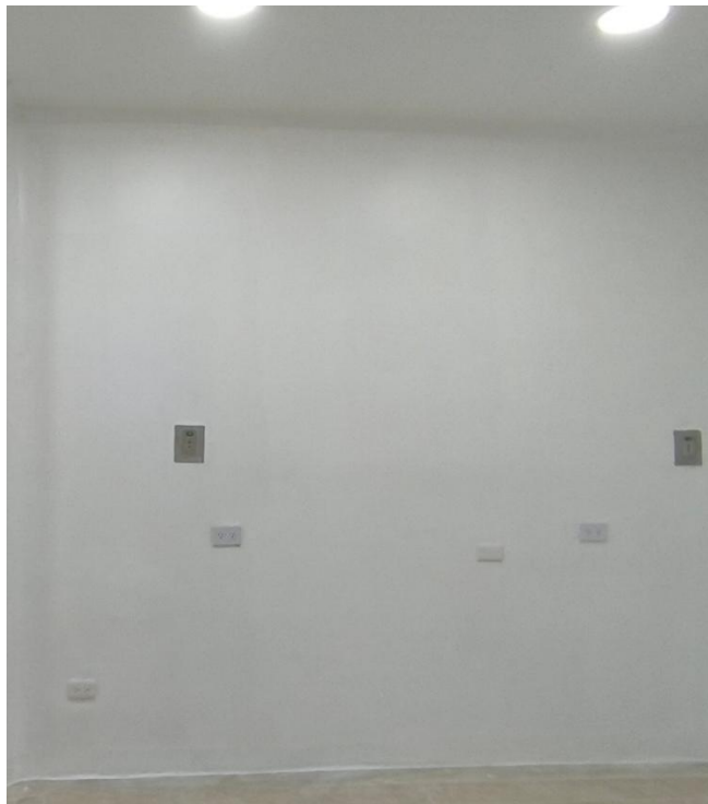
INSTALACION DE TOMAS ELECTRICAS
